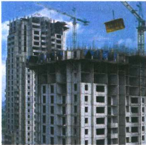
ساختمان در حال مقاومسازی با ورقهای FRP
