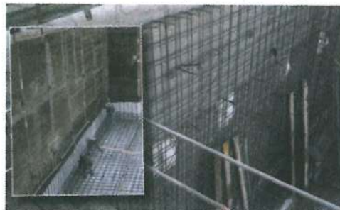
شکل ۳: هسته‌ی دیوار شاتکریتی نشان‌دهنده‌ی اثر پوشش گروت بر سوراخ‌های ایجادشده توسط شاتکریت است.
