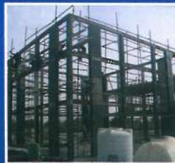
مسجد فرودگاه بین المللی قشم (EPC)
